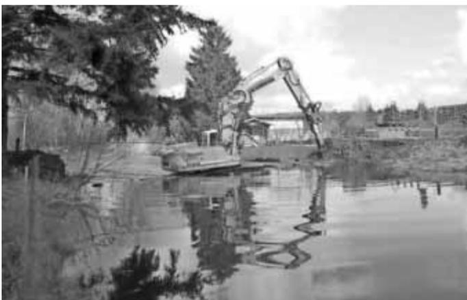
fallen. Auf diesem Abbruchmaterial konnten sie mit dem Bagger fahren und das Widerlager Ost abbrechen. Anschließend war es möglich im Rückwärtsarbeiten das gesamte Abbruchmaterial sauber aus der Riss zu bekommen.
