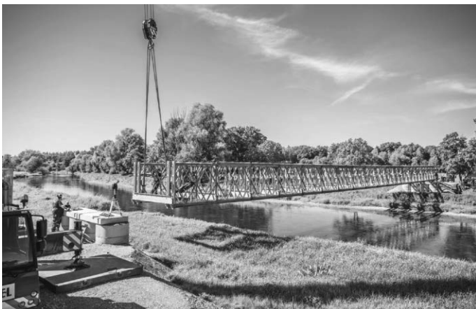
Ehrenamtliche des Technischen Hilfswerks haben am Wochenende die Behelfsbrücke errichtet. Bild: Technisches Hilfswerk
